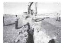
کندن زمین با بیل مکانیکی
